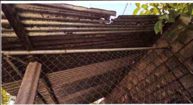
Foto1: Reparación de tubo hg de malla y galvanizada
