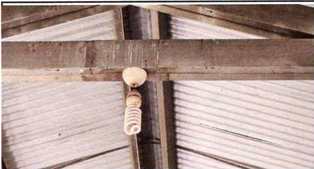
Foto 15: Reparación de lámparas
