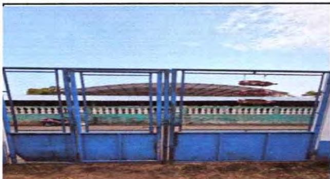
Foto 9: Sustrución Porton de metal
