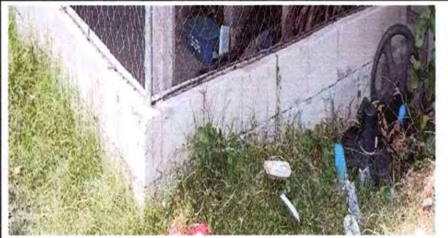
Foto 4: Reparación de muro perimetral de block
