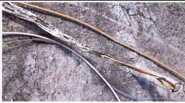
Foto 8: Reparación de sistema eléctrico
