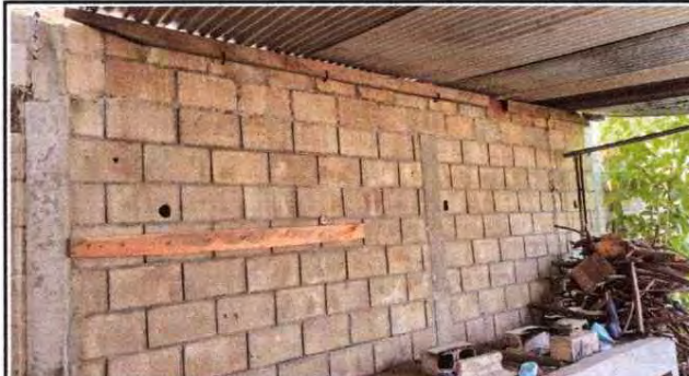
Foto 16: Repello en muro
