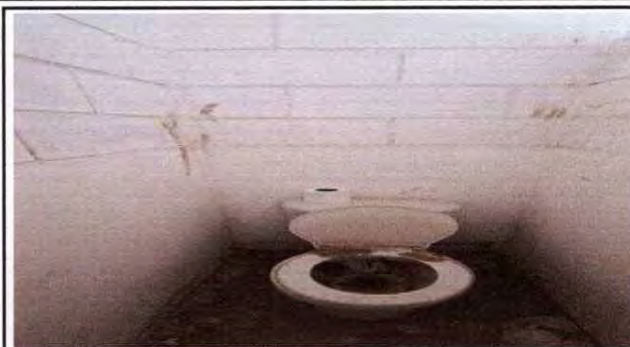
Foto 14: Sustitución de inodoros
