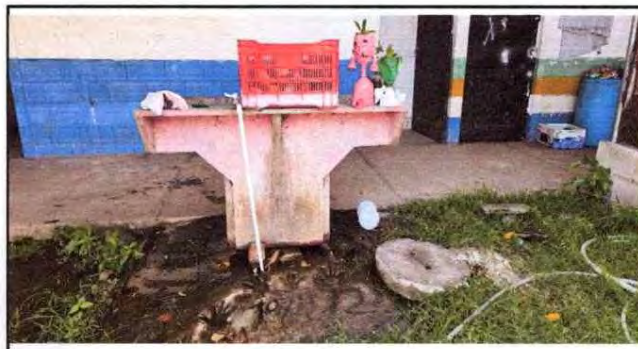
Foto 10: sustrución de Torta de cemento
