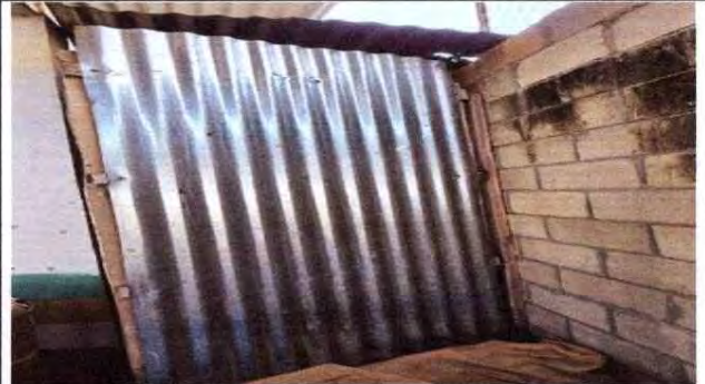
Foto 2: Sustitución de puerta de metal
