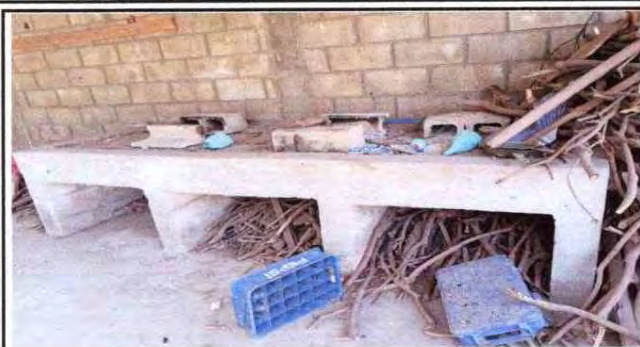
Foto 13: Instalación de azulejo en estufa rural
