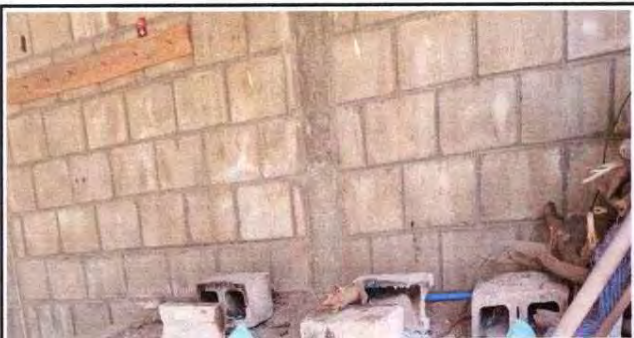
Foto 5: Pintura en muros exteriores e interiores
